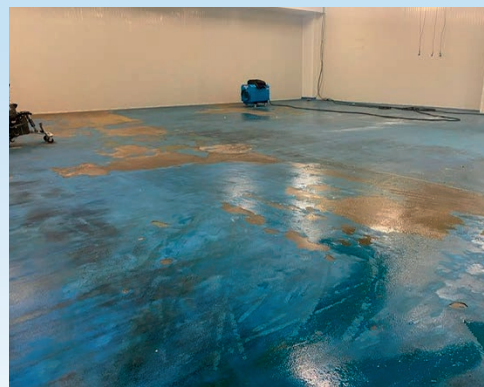
Kleinschalige vloerenrenovatie in beeld.
